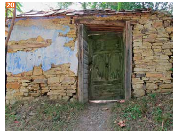
20 Gard zidit la Șona, veche gospodărie românească
