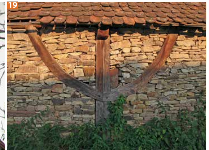
18-19 Șuri de la Șona. În gospodăriile de deal și de munte, șurile sunt construcții foarte importante, care adăpostesc cantități mari de fân pentru hrana animalelor peste iarnă. Unele se construiesc în întregime din lemn, altele cu pereții de piatră.
